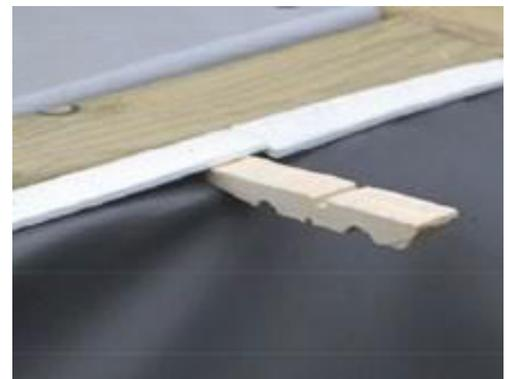
*Abb. 32 — Verkeilung der Folienauskleidung mithilfe der halben Wäscheklammern*
