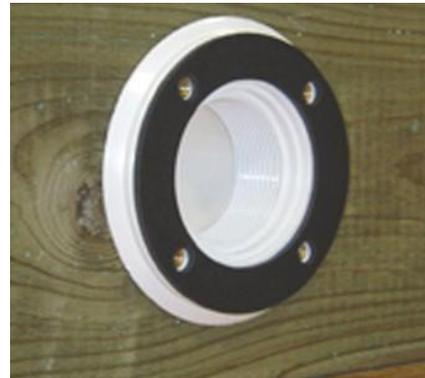
Abb. 24 – Montage der Einlaufdüse inkl. Dichtung
