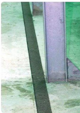
*Abb. 8 - Anbringen der Bitumenstreifen*
