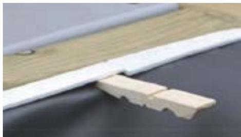
Abbildung 28 – Verkeilung der Folienauskleidung mithilfe der halben Wäscheklammern
