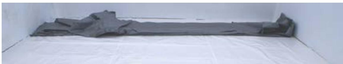
Abbildung 29 – Entfalten der Folienauskleidung
