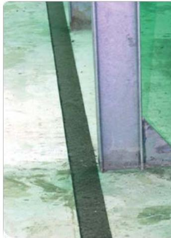
Abbildung 8 – Anbringen der Bitumenstreifen
