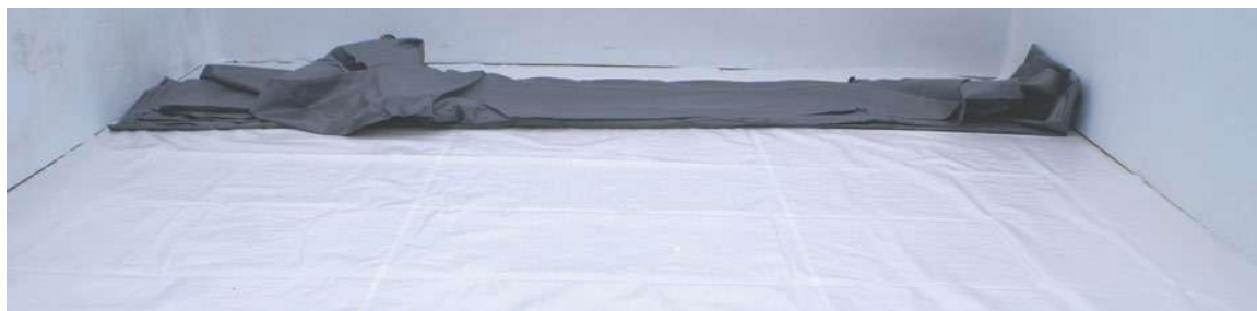
Abbildung 32 – Entfalten der Folienauskleidung
