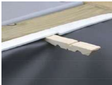
Abbildung 31 – Verteilung der Folienauskleidung mithilfe der halben Wäscheklammern
