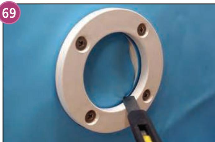
Schneiden Sie nun die Folie innerhalb der Flansche für Reinigeranschluss und Einlaufdüse heraus.
