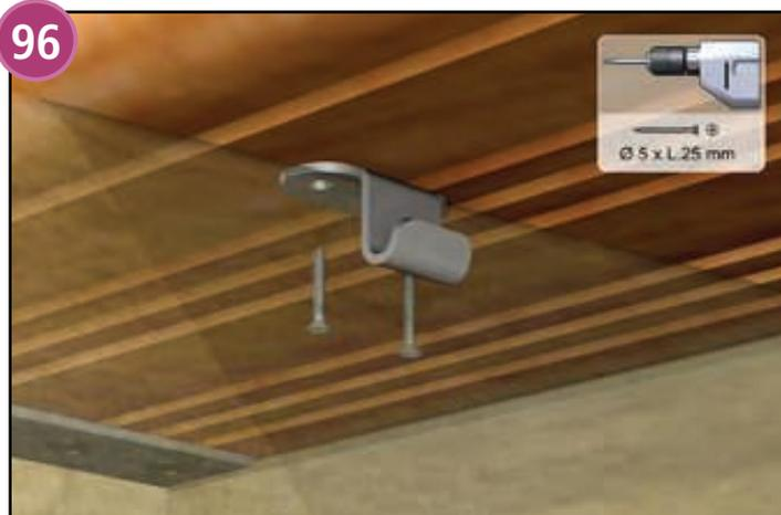
Die Holzleiter ist mit zwei Verriegelungen versehen, die die Leiter sicher an Ort und Stelle halten. Die Verriegelungen werden an den Leiterabstützungen angebracht und die Haken werden unter dem Handlauf montiert (diese Teile sind in Pack K enthalten). Schauen Sie sich dabei genau an, wie diese beiden Teile ineinandergreifen, damit Sie den Mechanismus verstehen lernen und besser einschätzen können, welchen Weg die Leiter nehmen muss, bevor sie sicher eingerastet ist.
