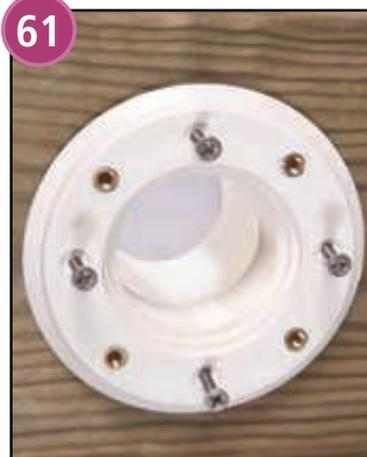
Setzen Sie von der Poolseite aus die Wanddurchführung für die Einlaufdüse (Einbauteile-Set) in die dafür vorgesehene Öffnung ein. Befestigen Sie sie mit Hilfe der selbstschneidenden Schrauben 3x25. Versehen Sie jede Wanddurchführung mit einer selbstklebenden Dichtung. Schrauben Sie von Hand, um das Holz nicht zu beschädigen.
