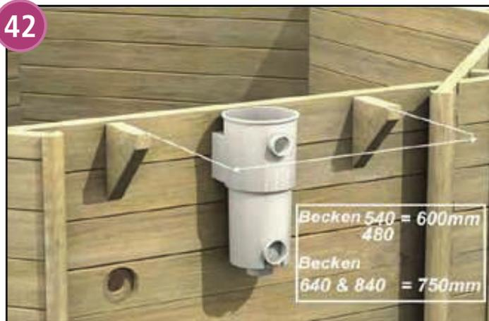
Montieren Sie 2 Holzkeile an der Wand, die den Skimmer beherbergt. Die Keile sollten jeweils den gleichen Abstand zum Skimmer aufweisen.
