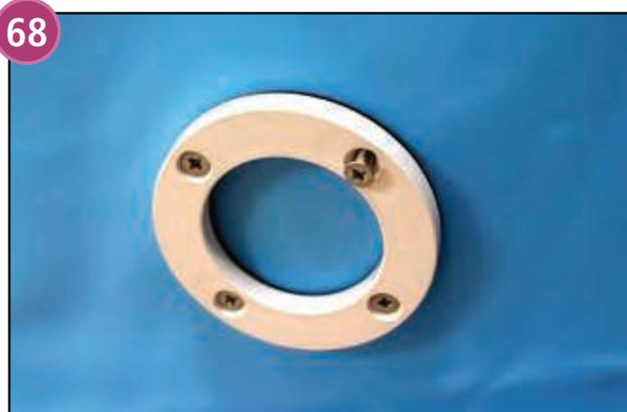
Schrauben Sie den Flansch (mit dessen Dichtungsring) mit Hilfe der im Einbauteil-Set enthaltenen Edelstahlschrauben M5x16 fest. Ziehen Sie die Schrauben nacheinander mit der Hand an, um absolute Leckdichtheit zu erreichen. Ein übermäßiges Anziehen der Schrauben könnte jedoch den Flansch beschädigen.
